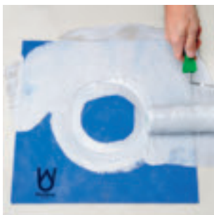
Applicera AquaStop på golvet och på brunnsmanschetten.
