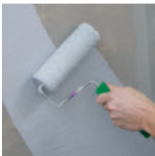
Applicering av 2:a lagret AquaStop.
