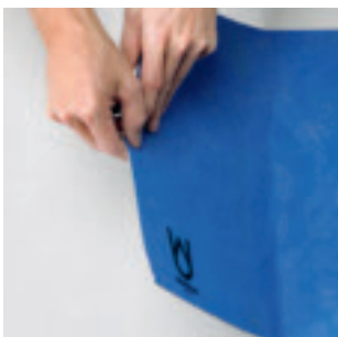
Avlägsna skyddspappret på Brunnsmanschetten och montera över brunnhålet. Var noggrann så det inte bildas luftfickor eller blåsor.
