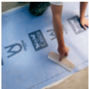
Applicera WetStop lim på golvet och runt brunnsålet. Tryck fast WetStop-mattan med Gnidde. Låt torka minst 24 timmar.
